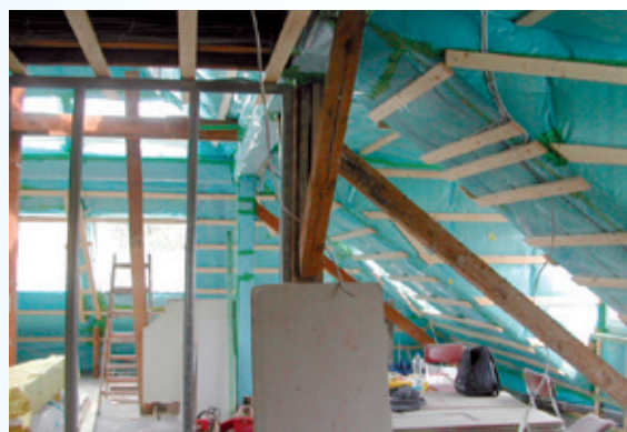
Die luftdichte Ebene ist noch sichtbar und zugänglich (Folie und Holzbauplatte): Der optimale Zeitpunkt für eine BlowerDoor Messung.
